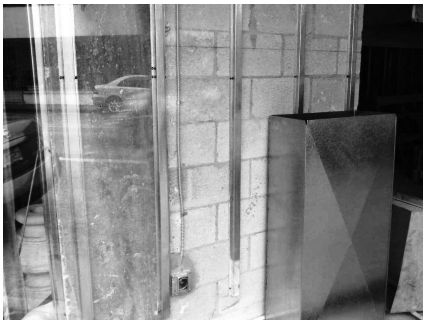
FIGURA 16: Perfis metálicos para fixação de placas em gesso acartonado em obra nos Estados Unidos (agosto de 2008).
