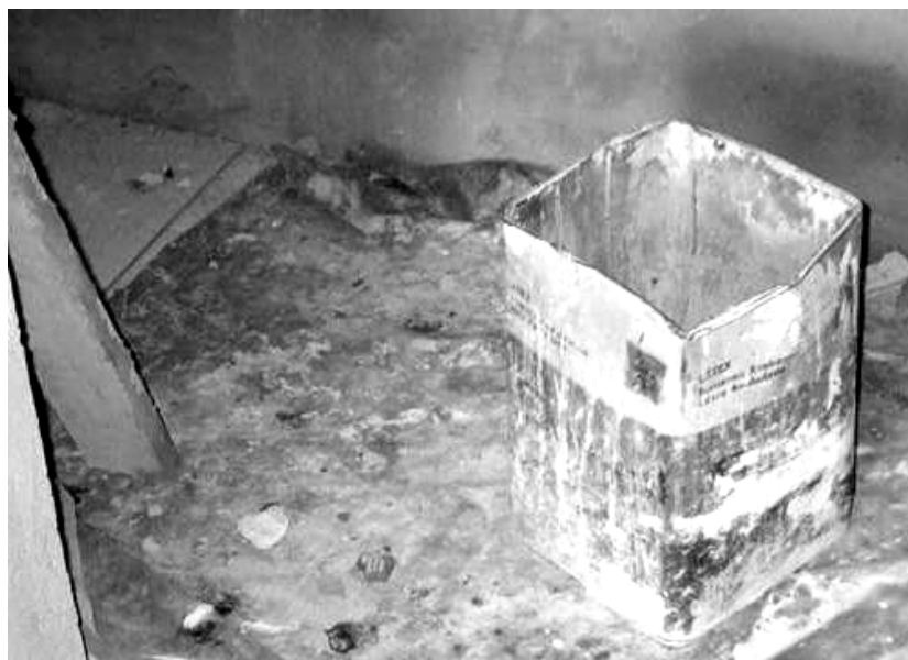
FIGURA 13: Embalagem vazia, mal acondicionada Tinta em canteiro de obra com implementação de gestão de resíduos
