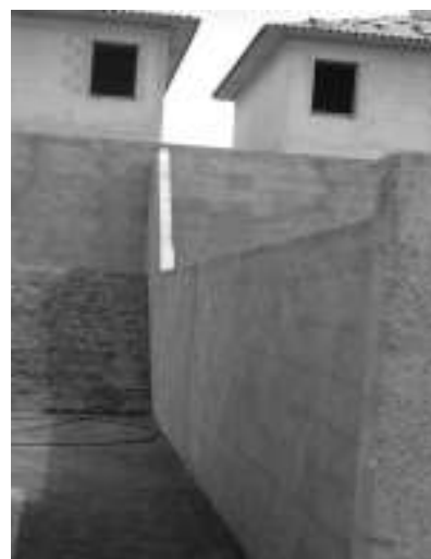
Figura 17. Muro executado com blocos de 14 cm de espessura (eliminação da necessidade de reforço)
