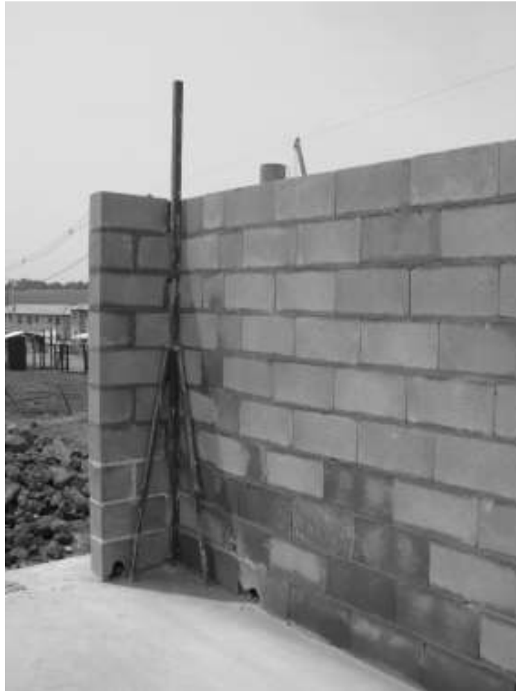
Figura 21. Detalhe do escantilhão para execução de alvenaria
