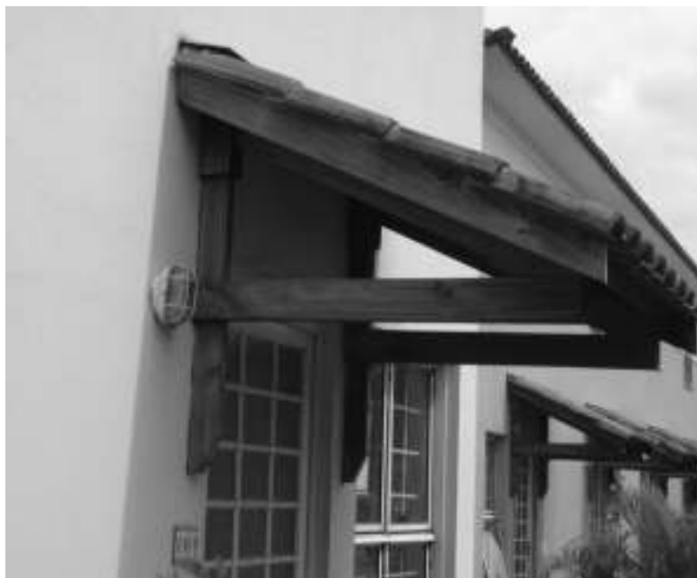
Figura 19. Telhados de varandas executados com chapa metálica de fixação (eliminação da recorrência do envergamento)
