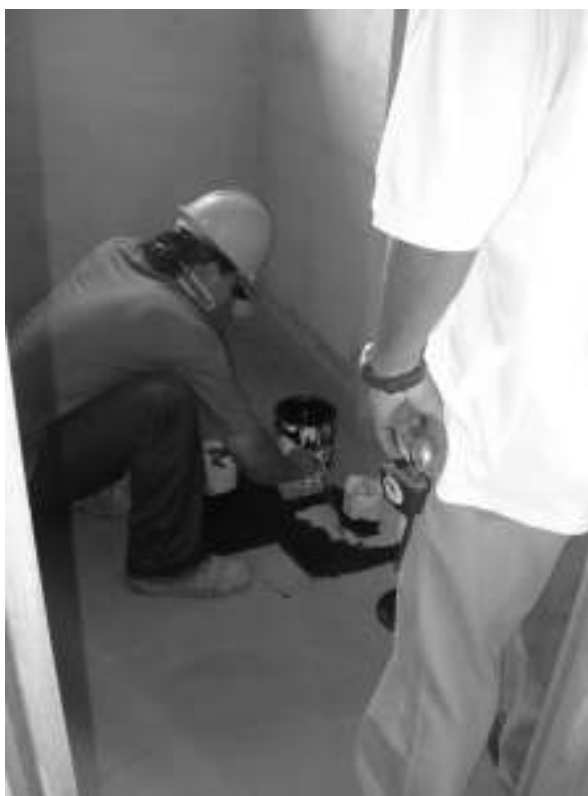
Figura 22. Detalhe de operário executando impermeabilização
