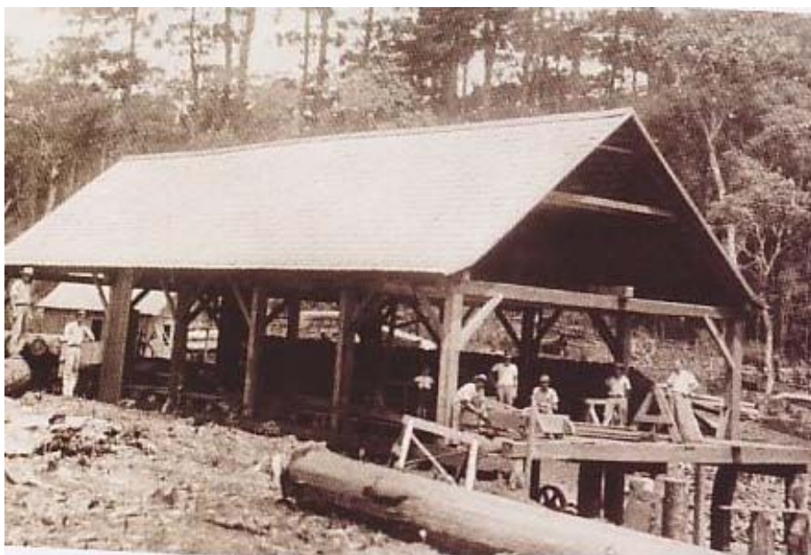
Figura 4: Serraria movimentada por locomóvel em Pato Branco
