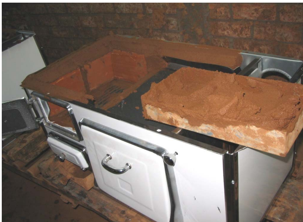
Figura 19: Fogão a lenha sobre roletes em processo de colocação de tijolos.
