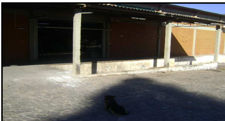
Figura 26 - Área de carregamento de caminhões
