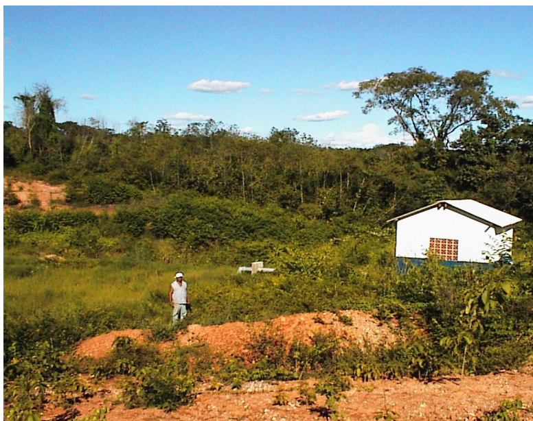
Figura IV.13 – Casa de Bombas de Captação D'água.
